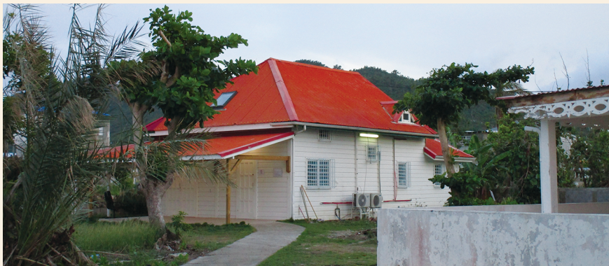
Figure 1 : Toiture ayant résisté
